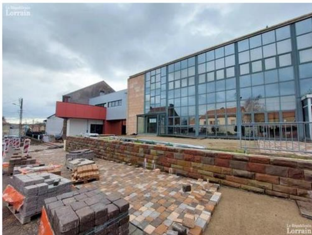
Au village, le chantier de l'espace associatif, rue de l'École, se termine. Photo RL /Gaëlle KRAHENBUHL
