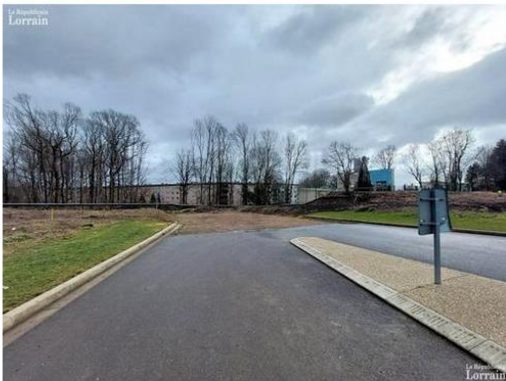
La nouvelle voie d'accès à la ville est déjà bien entamée. Il faut encore enterrer la conduite du chauffage urbain, qui passe sur le terrain. Photo RL /Gaëlle KRAHENBUHL
