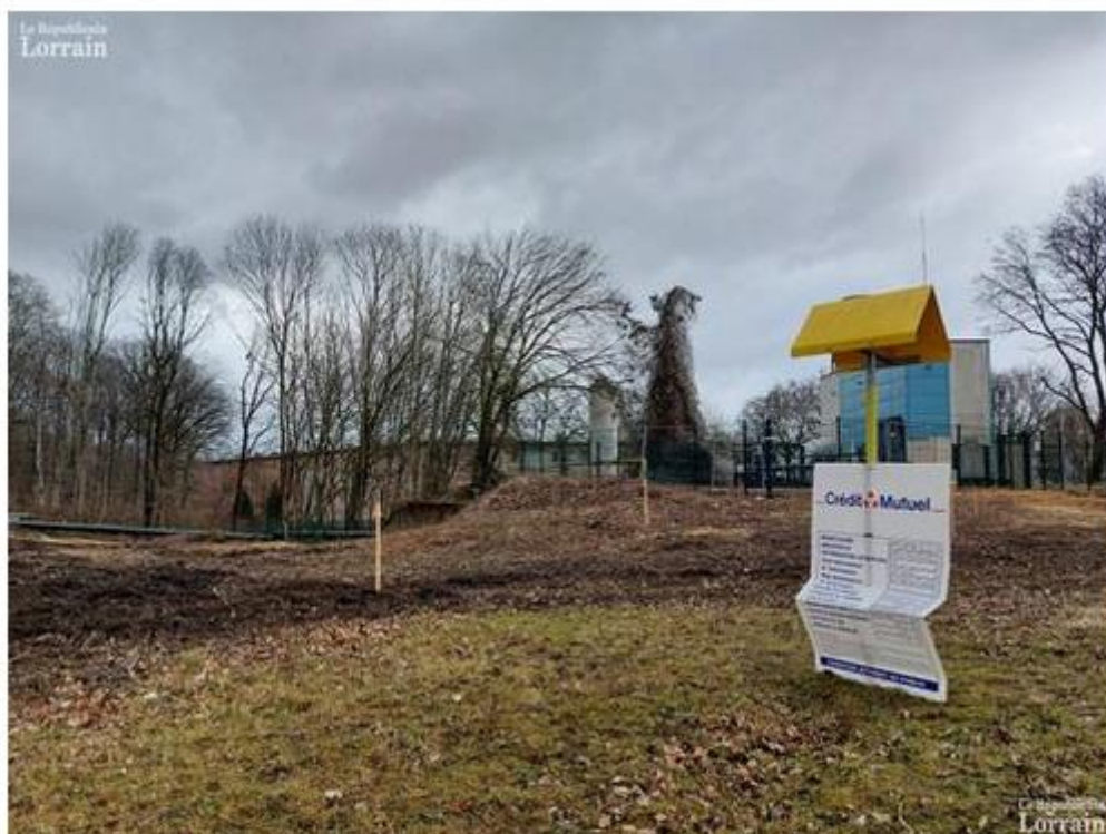
L'agence du Crédit Mutuel va s'installer entre la rue des Cévennes et la rue de Forbach. Photo RL /Gaëlle KRAHENBUHL
